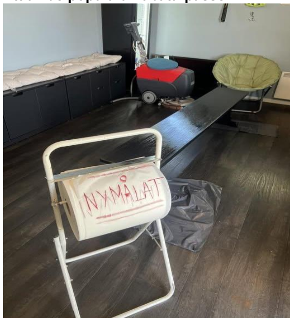
Renovering av hallen pågår!
